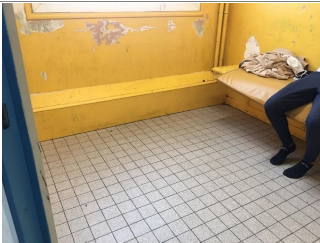
Cellule de garde à vue dans un commissariat de police © CGLPL
